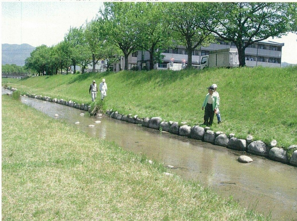
実施状況 第二古川の低水護岸及び遊歩道の点検
