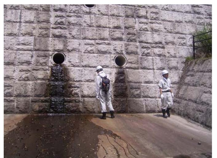
水抜き穴やコンクリートのひび割れなどの確認
