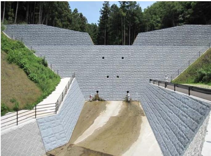
流路工の堆積土砂や、コンクリートのひび割れなどを確認(四季が丘3号砂防えん堤下流部)
