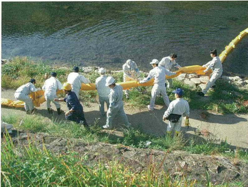
オイルフェンスの設置作業
