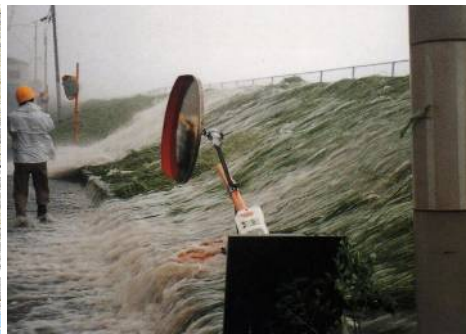
平成11年9月高潮堤防超水状況 (広島市西区観音新橋地先)
