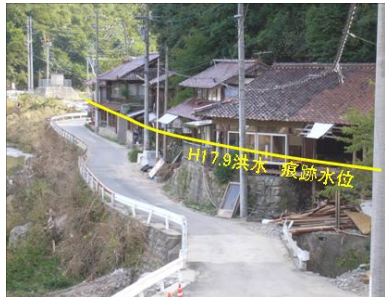
洪水被災痕跡水位 (広島市安佐北区安佐町大字久地地先)
