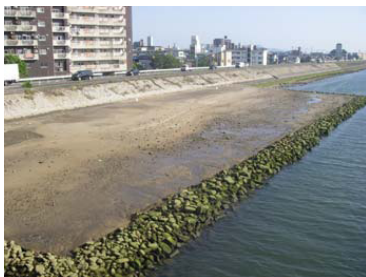
「太田川生態工学研究会」において実施されている干潟再生試験で造成された干潟の状況
