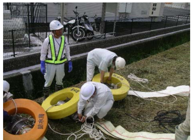
ポンプ設置状況
