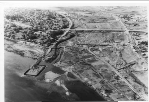
建設中の祇園・大芝水門
