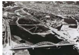
河道締切中の福島川と掘削中の放水路
