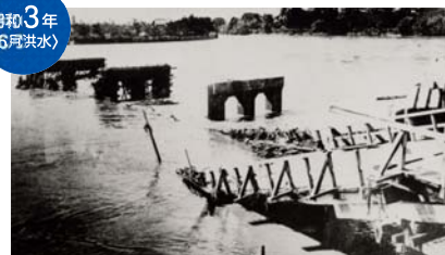
広島市常盤橋流失
