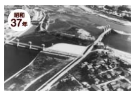
完成した祇園水門と工事中の大芝水門
