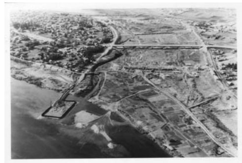
太田川放水路建設の様子
