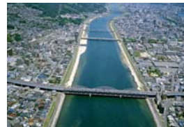
現在の放水路
