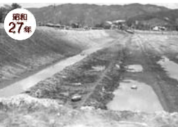
掘削中の放水路
