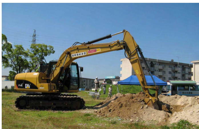
遠隔操縦装置「ロボQ」を装着した施工機械による訓練実施状況
