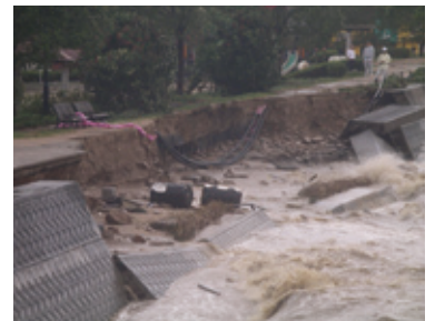
被災状況（中区吉島）
