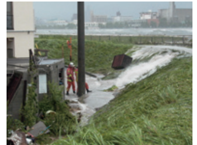
浸水状況（西区観音新町）
