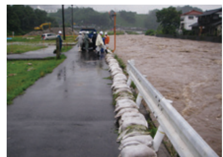
平成 22 年 7 月 根谷川土囊積み状況
