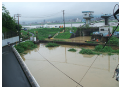
矢口川被害状況
