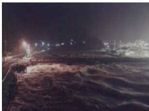
平成17年9月洪水時の様子(太田川61.7k 堂見橋下流右岸)
