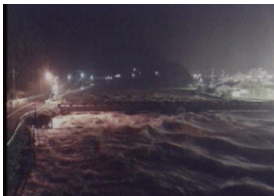
堂見橋洪水時（平成 17 年）
