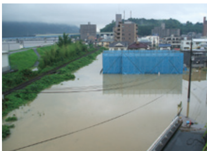
矢口川被害状況
