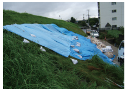
太田川右岸 12k500 法崩れ箇所応急復旧状況
