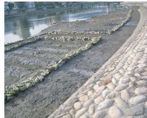
石炭火力発電所から出る石炭灰を粒状に固めた「石炭灰造粒材」を埋め込んだ状況です。
