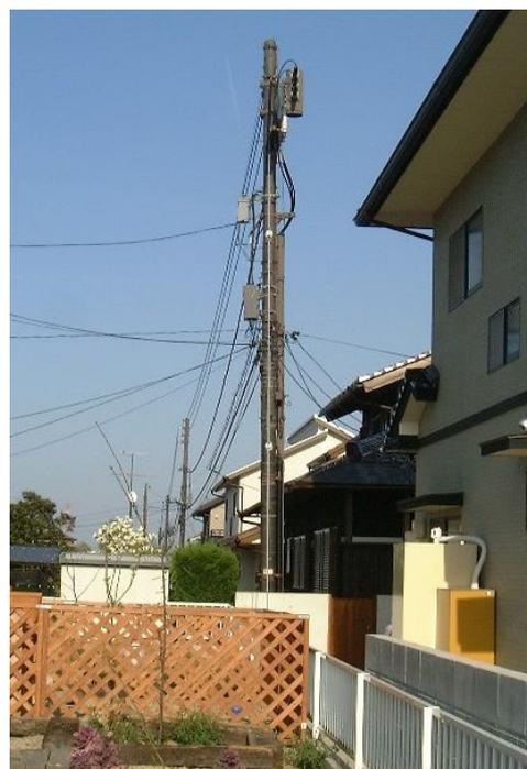
写真 1-3 民地利用方式（柱設置）実施箇所例
