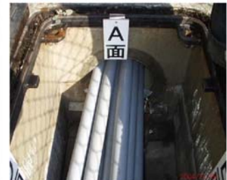
管路せり出し
