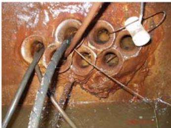
管路周辺の破損、およびせり出し
