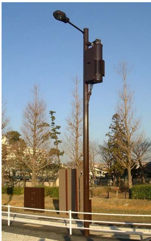
写真 1-4 マルチポール方式実施箇所例
