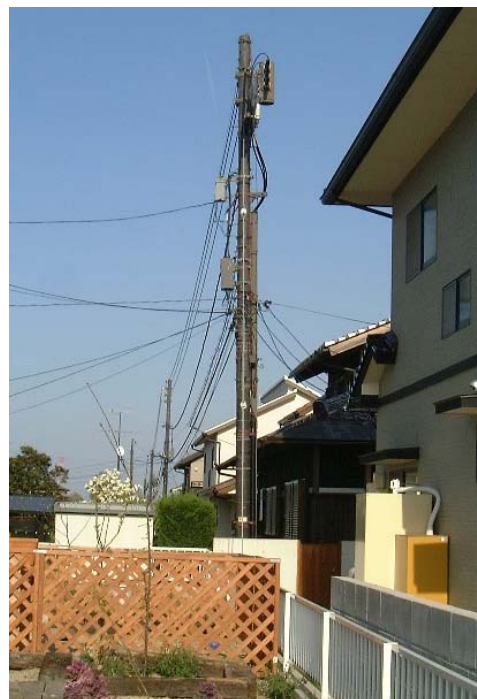
写真 1-3 民地利用方式（柱設置）実施箇所例
