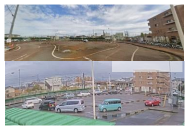
現状の西口駅前広場
