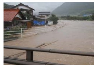
山口県萩市浸水状況
