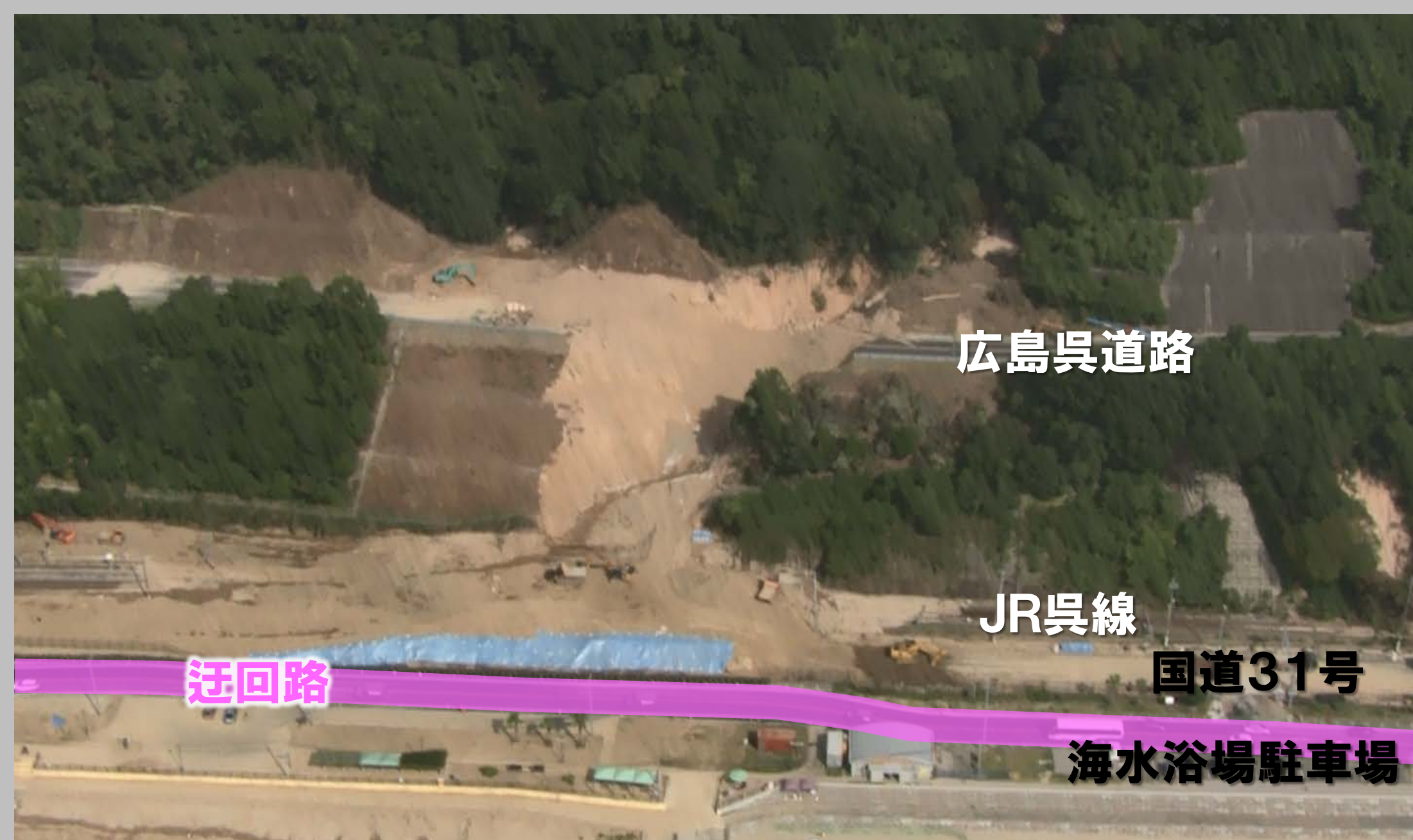
■迂回路整備後(平成30年7月12日撮影)
