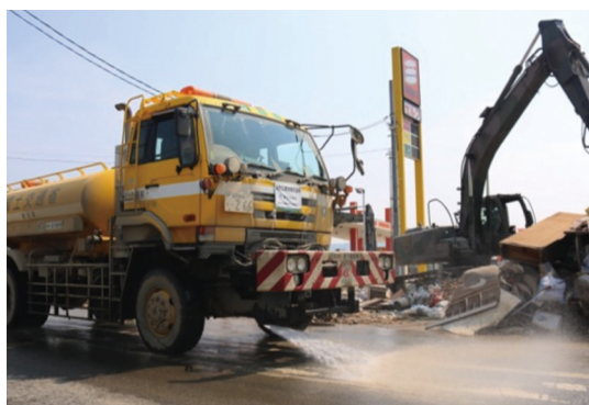
粉じん対策（散水）状況
