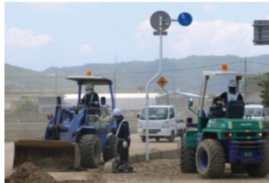
道路啓開状況
