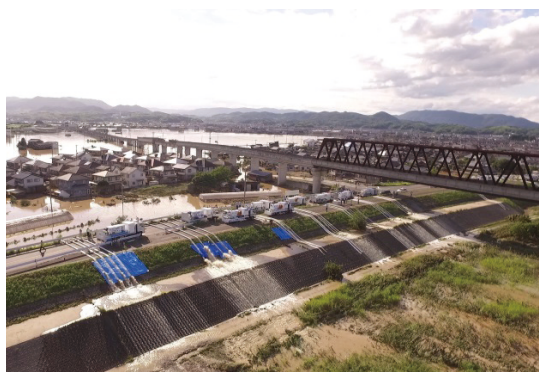
排水ポンプ車稼働状況（倉敷市真備町）
