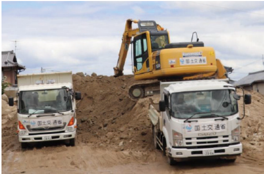
現場内土砂仮置き場整備（民地）
