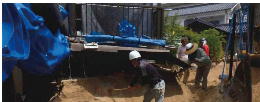
民地内土砂撤去状況：坂町小屋浦地区
