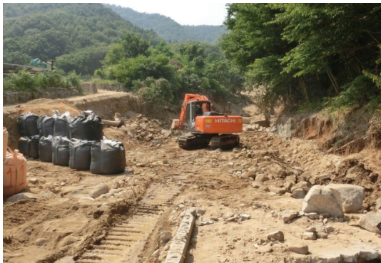
道路啓開作業（三原市）
