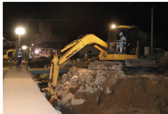
河川土砂撤去夜間作業（坂町坂西）
