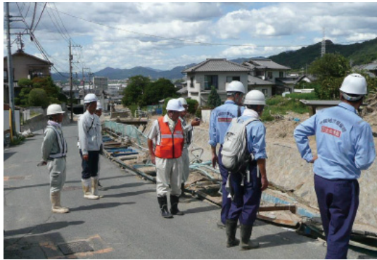
立会確認（坂町坂西）
