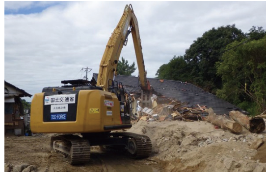
進入路整備（倒壊家屋撤去）
