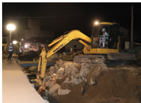
河川土砂撤去夜間作業（坂町坂西）
