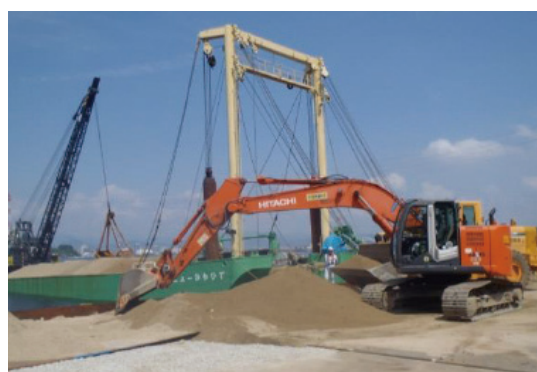
フェリーバージへの積み込み状況
