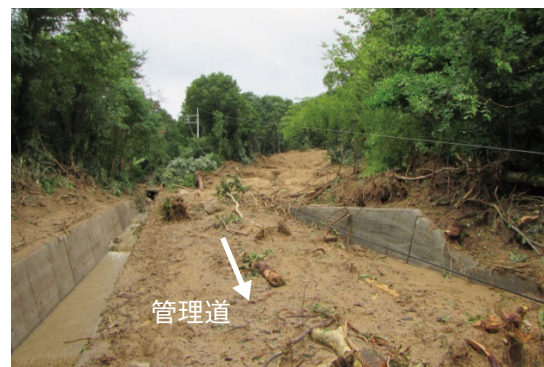
平谷無線中継所の管理道の土砂崩落
