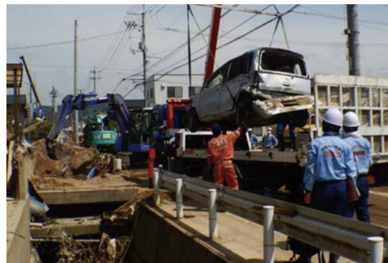
放置車両撤去状況
