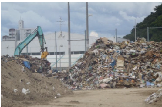
災害ゴミ集積状況（坂町）
