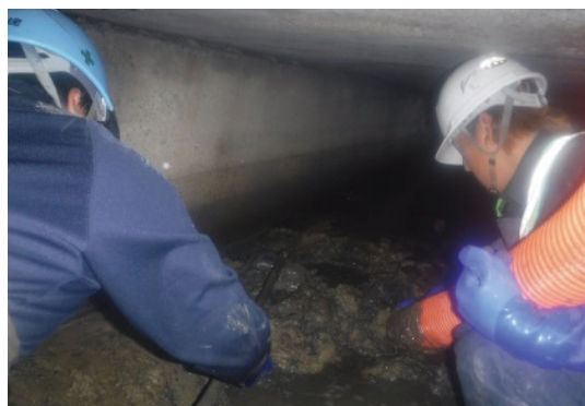
坂町内の側溝清掃作業
