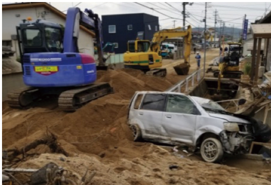
道路啓開状況
