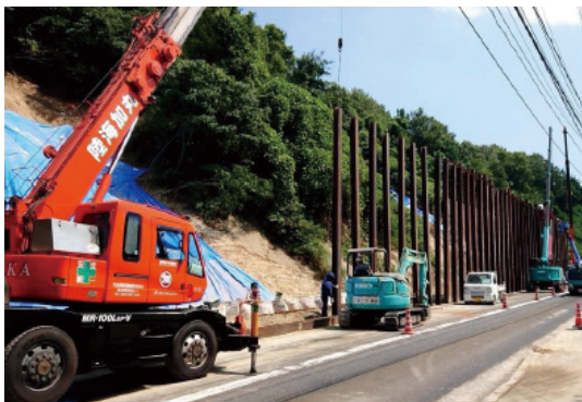
土工用防護柵設置作業（尾道市）
