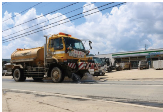
散水車稼働状況
