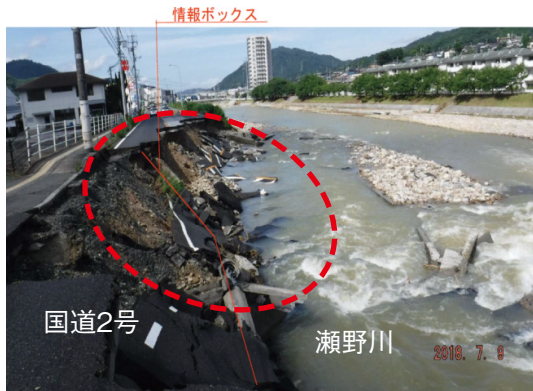
国道2号の光ケーブル断線
