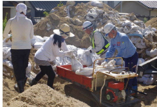
ボランティアによる土砂搬出作業
