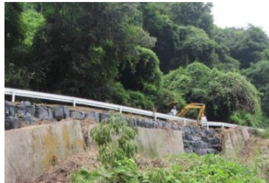
道路啓開作業（福山市）
