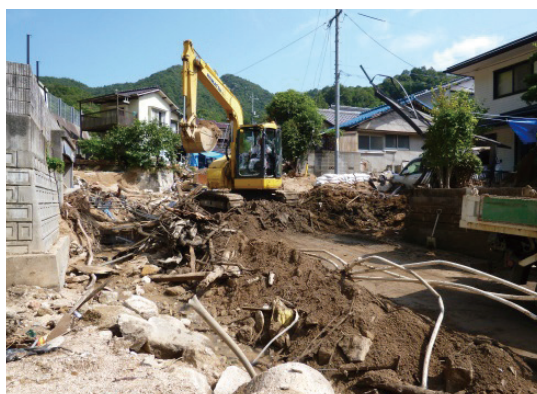
道路啓開作業（坂町小屋浦）
