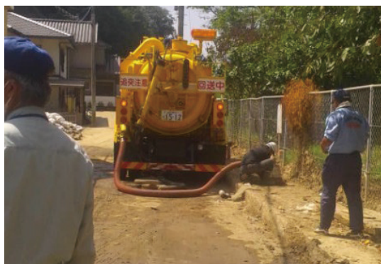
坂町内の側溝清掃作業（配水管清掃車）
