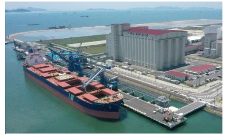
水島港 穀物バルク施設
