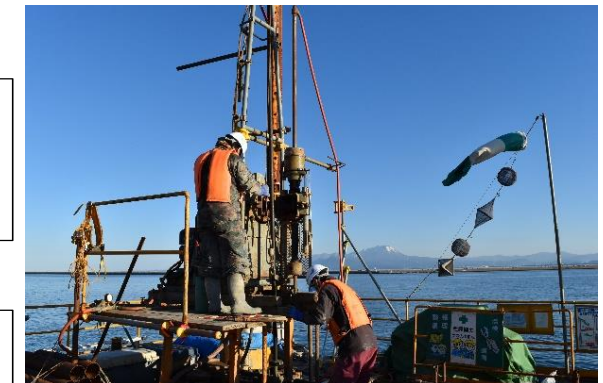
海底地盤の調査(土質調査)
