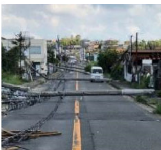
<電柱の倒壊による道路閉塞の事例>
