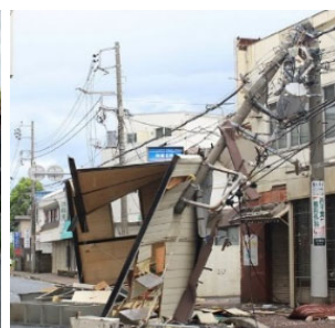
<飛来物による電柱倒壊の事例>
