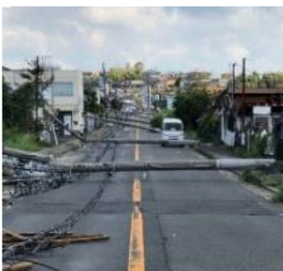
<電柱の倒壊による道路閉塞の事例>
