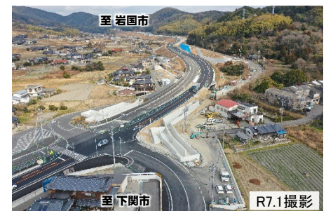
【写真②】富海交差点付近の施工状況
