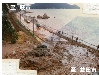
【写真③】S55年土砂崩壊の状況
