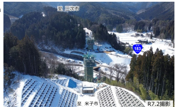
【写真①】新屋地区の施工状況
