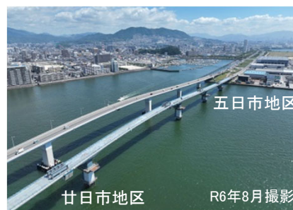
上部工架設完了
