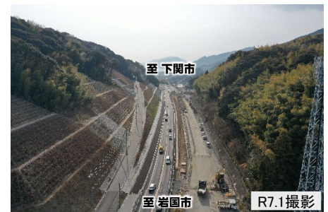
【写真①】橋地区の法面施工状況
