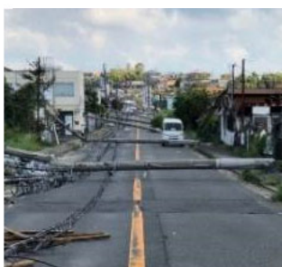
<電柱の倒壊による道路閉塞の事例>
