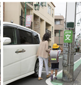
<歩行の支障となる電柱の事例>
