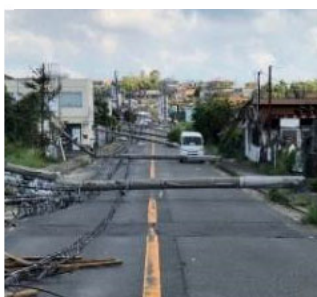
<電柱の倒壊による道路閉塞の事例>
