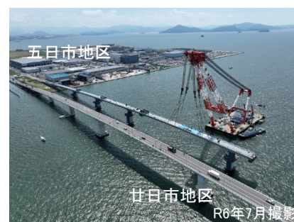
上部工架設状況
