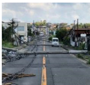
<電柱の倒壊による道路閉塞の事例>
