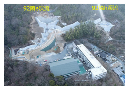
砂防堰堤の整備状況
