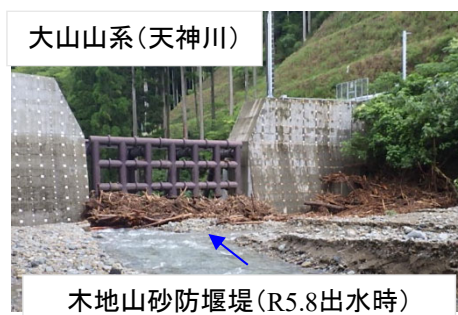
土砂・流木捕捉事例
