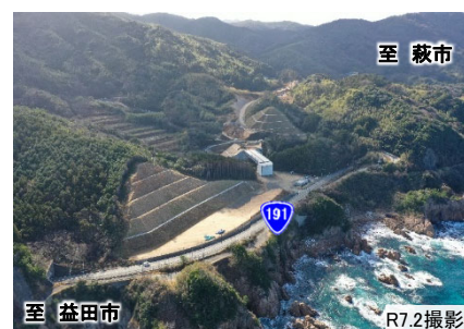
【写真①】宇田地区の施工状況
