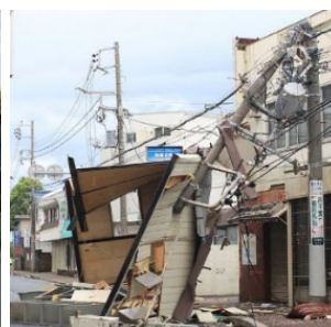
<飛来物による電柱倒壊の事例>
