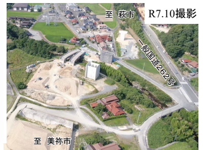
【写真②】明木地区 施工状況
