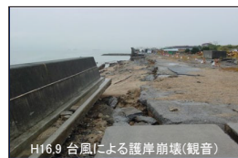
H16.9 台風による護岸崩壊(観音)
