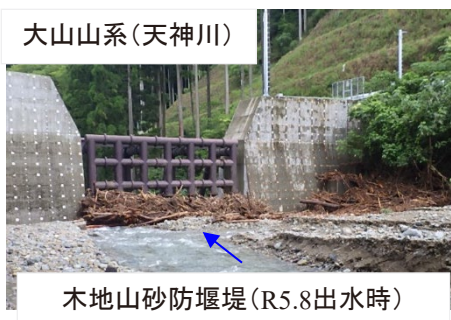
土砂・流木捕捉事例
