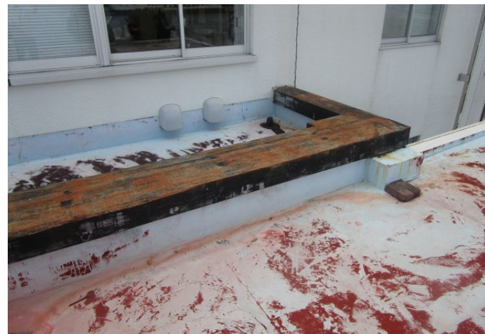
現況写真(屋上)
