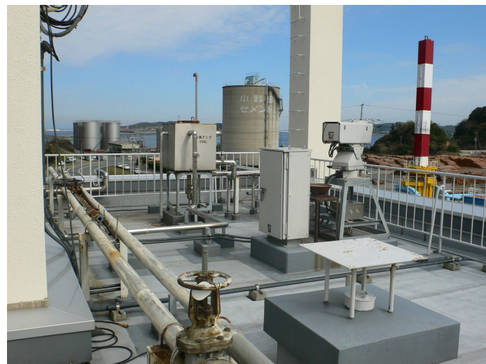
現況写真(屋上)
