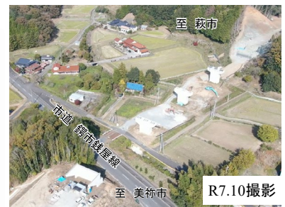
【写真①】2号橋付近施工状況
