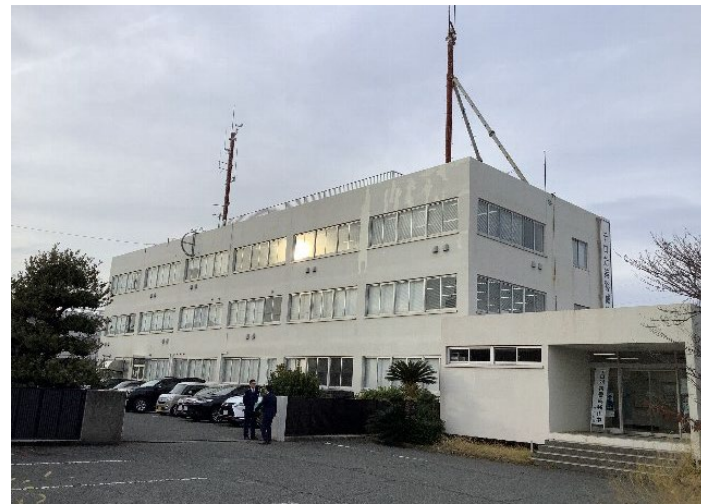
現況写真(外観)
