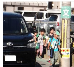
＜歩行の支障となる電柱の事例＞
