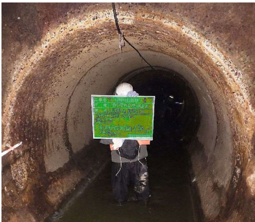
合流式下水道管 Φ2,100
