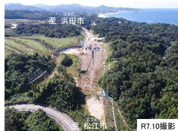
【写真①】福光地区の施工状況
