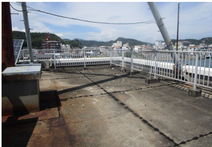
現況写真(屋上)
