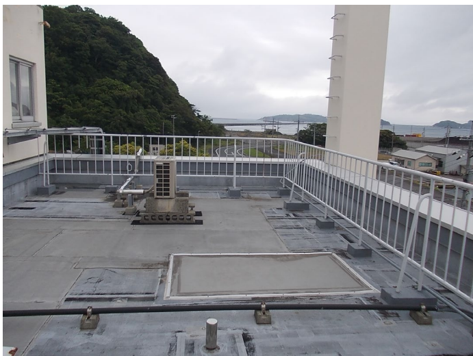
現況写真(屋上)
