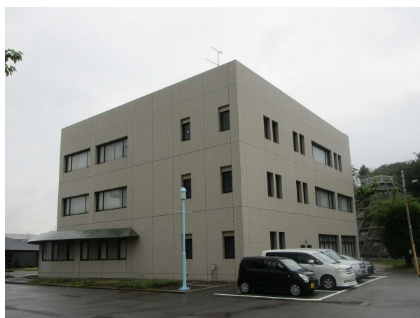
現況写真(外観)
