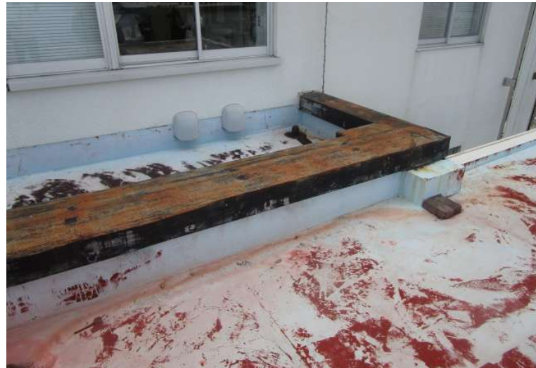
現況写真(屋上)
