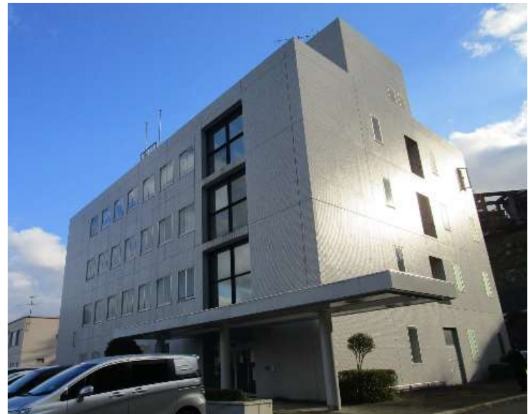
現況写真(外観)
