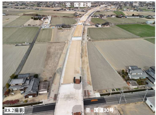
【写真①】 藤田地区 施工状況
