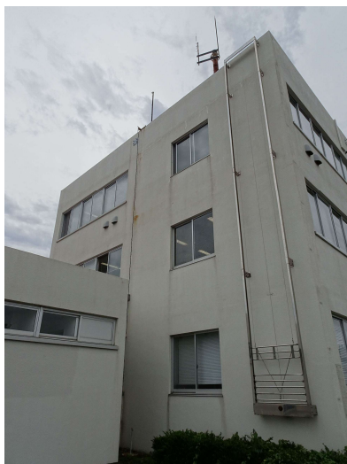
現況写真(外壁)
