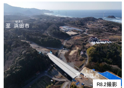
【写真②】本谷地区の施工状況
