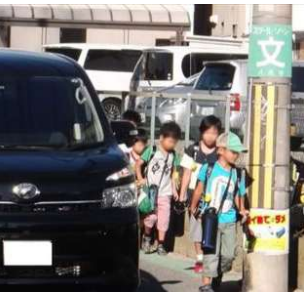
＜歩行の支障となる電柱の事例＞
