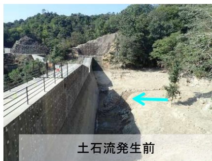
とりごえがわいちごう みどりい やぎ 鳥越川1号砂防堰堤(緑井・八木地区)の土石流捕捉事例
