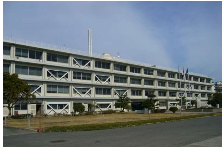
現況写真(外観)
