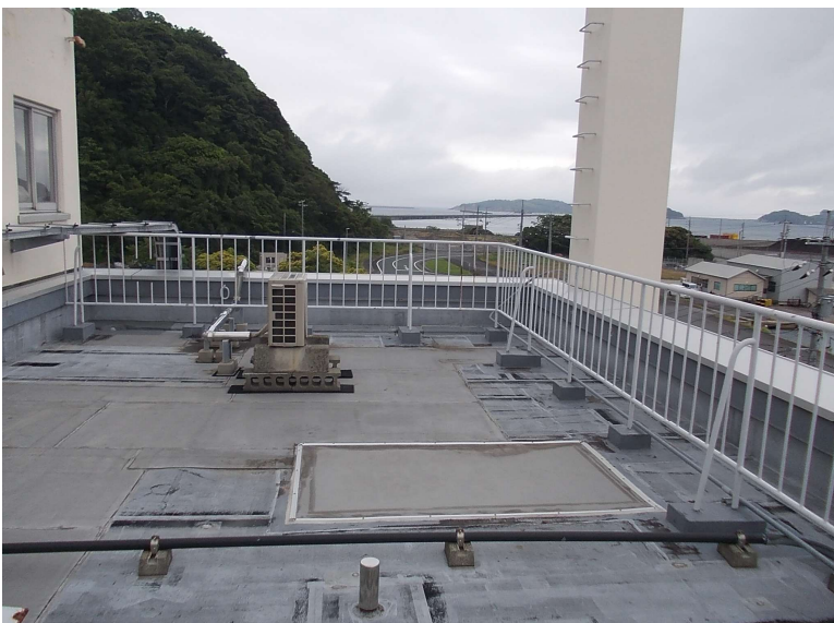
現況写真(屋上)
