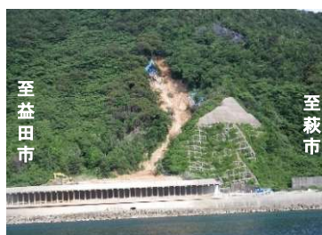
【写真③】H23年土砂崩壊の状況
