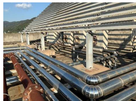
現況写真(屋上機械設備)
