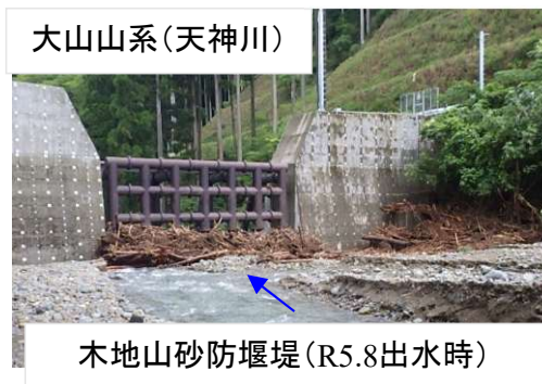
土砂・流木捕捉事例
