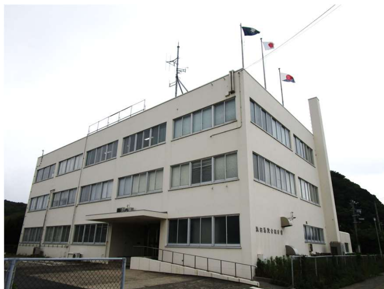
現況写真(外観)
