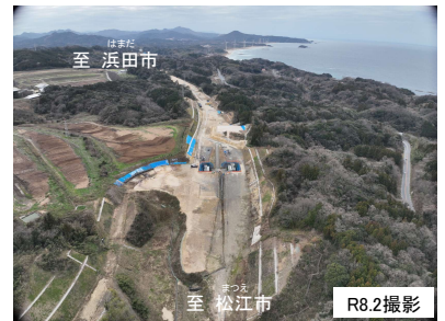
【写真①】福光地区の施工状況
