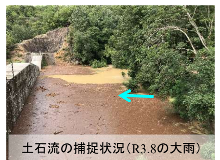
とりごえがわいちごう みどりい やぎ 鳥越川1号砂防堰堤(緑井・八木地区)の土石流捕捉事例
