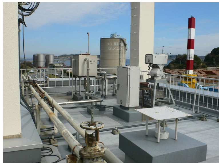
現況写真(屋上)
