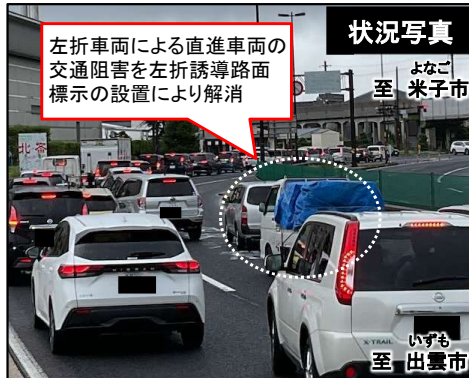
国道9号 袖師交差点 (島根県 松江市)
