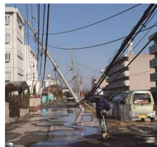
＜飛来物による電柱倒壊の事例＞
