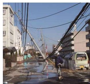
<飛来物による電柱倒壊の事例>
