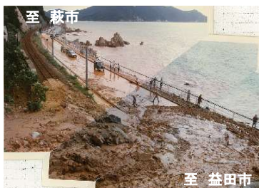
【写真②】S55年土砂崩壊の状況
