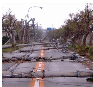
<電柱の倒壊による道路閉塞の事例>
