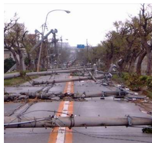
＜電柱の倒壊による道路閉塞の事例＞
