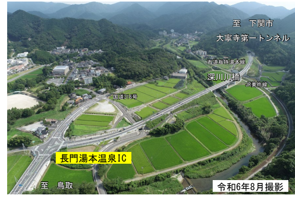
長門湯本温泉IC付近の状況 (写真②)
