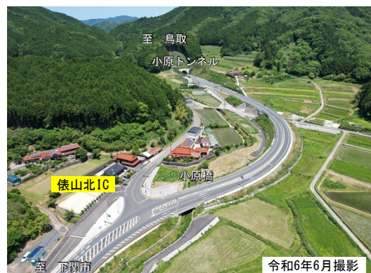
俵山北IC付近の状況 (写真①)
