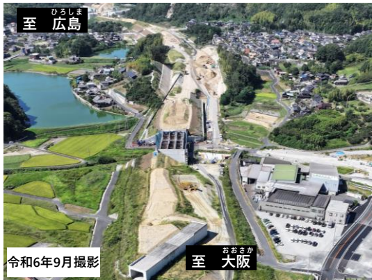
【写真③】鴨方IC付近の進捗状況
