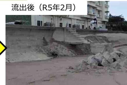
▲侵食による護岸法先の露出（皆生工区）
