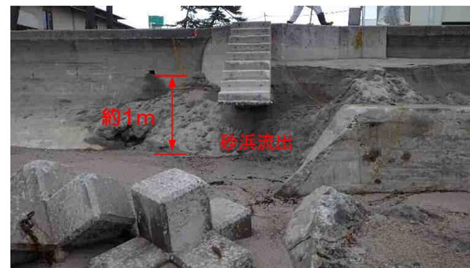
海岸侵食の激しい富益工区（平成23年9月7日砂浜の損失）
