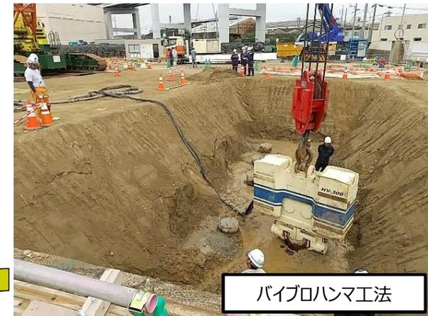
変更後の鋼管矢板引抜工法
