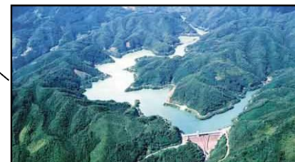
【島地川ダム】 国管理 形式 : 重力式コンクリートダム 堤高 : 89m 堤頂長 : 240m 集水面積 : 32km 2 管理開始 : 昭和57年4月
