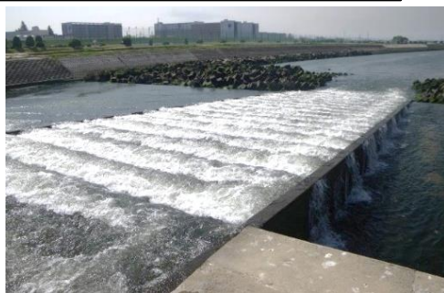
【改良前の1号魚道】
