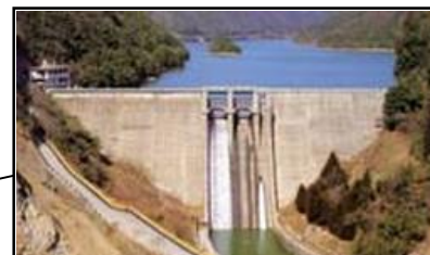
【佐波川ダム】 県管理 形式 : 重力式コンクリートダム 堤高 : 54m 堤頂長 : 156m 集水面積 : 88.4km 2 管理開始 : 昭和31年4月
