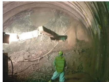
鏡吹付け施工の様子
