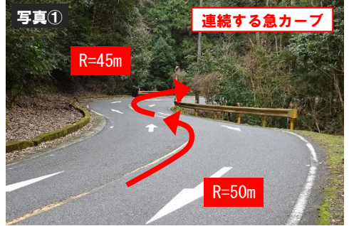
▼(主)下関長門線の平面線形不良箇所
