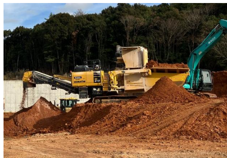
▼攪拌機による石灰の混合改良
