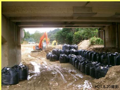
すがわ ▲素川 JR高架橋付近土砂撤去完了
