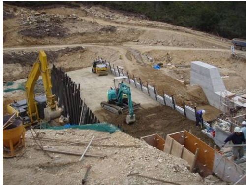
つるぎがわ ▲剣川 ソイルセメント打設状況
