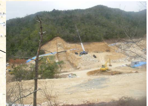
なみがわ ▲奈美川 掘削状況
