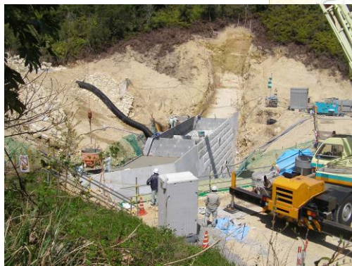
かみさとがわ ▲神里川 コンクリート打設状況
