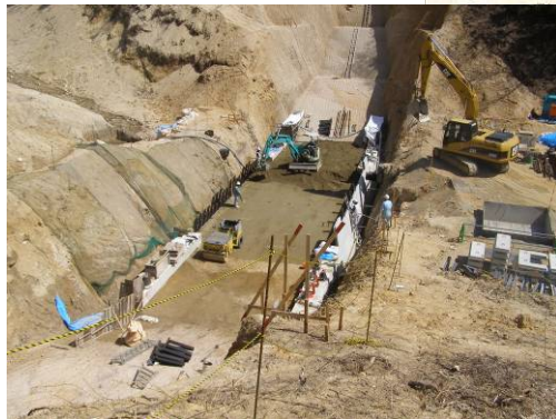
すがわ ▲素川 ソイルセメント打設状況
