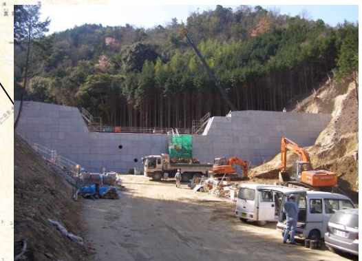
うえだみなみがわ ▲上田南川 コンクリート打設状況
