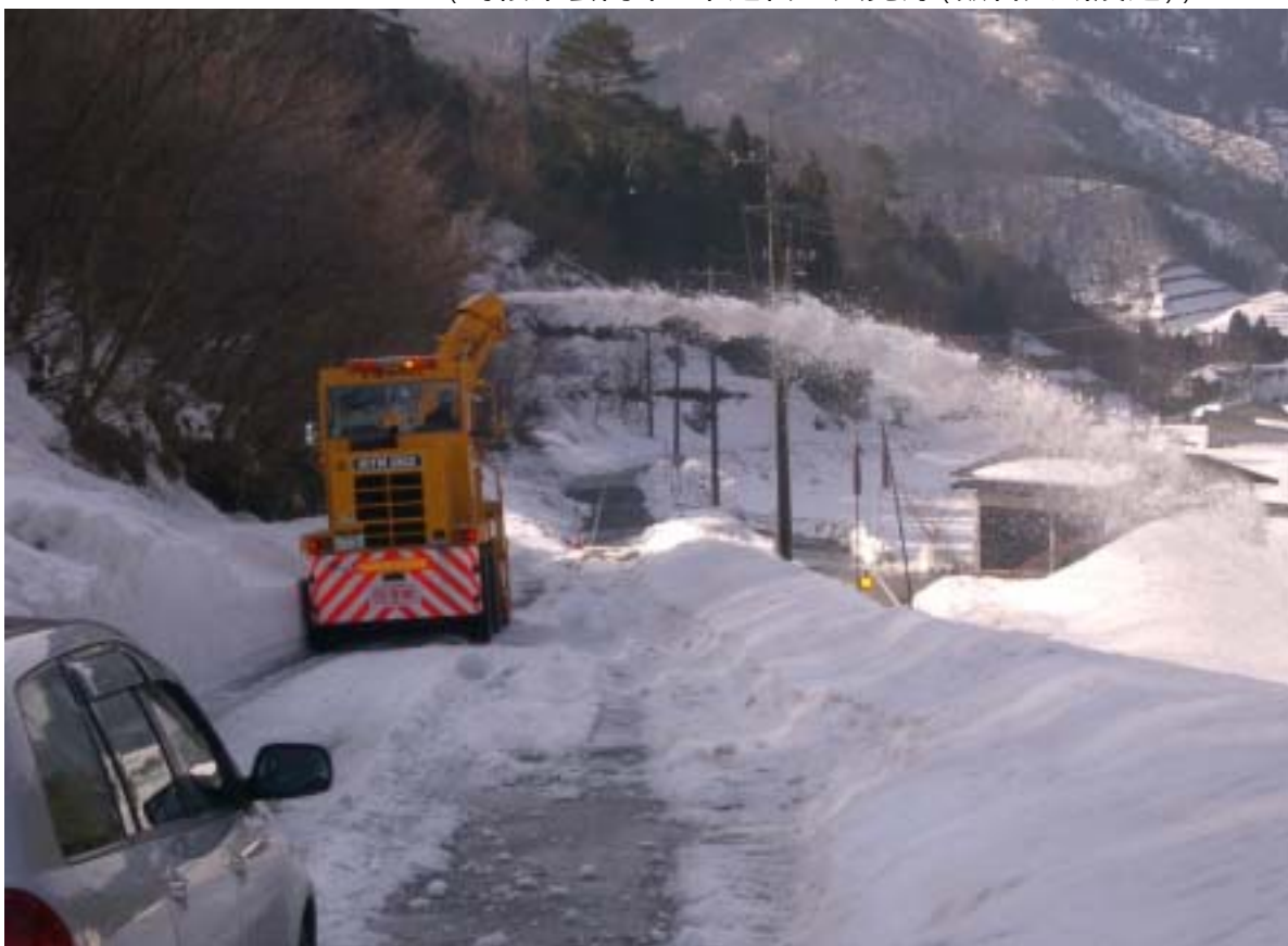
除雪作業状況写真（平成18年1月16日撮影） （島根県雲南市 市道松笠穴見線（飯石広域農道））
