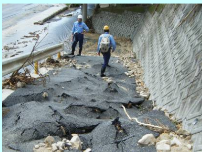
▲ 国道262号地区調査状況(道路)
