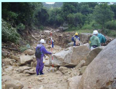
▲ 国道262号地区調査状況(砂防)
