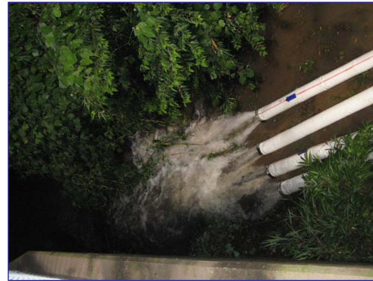
▲ ポンプ排水状況
