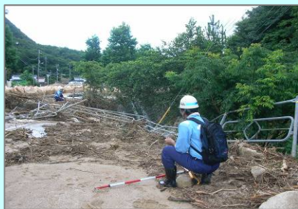
▲ 国道262調査状況(道路)
