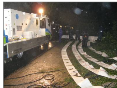
▲ 排水ポンプ車設置状況
