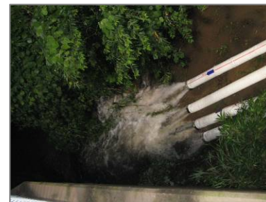
▲ 排水ポンプ車による排水状況
