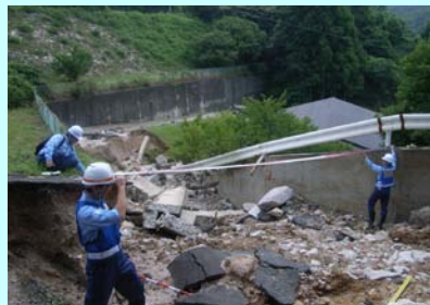
▲ 大道地区調査状況(道路)
