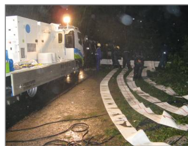
▲ 排水ポンプ車設置状況
