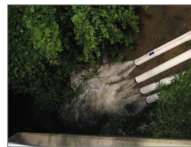
▲ 排水ポンプ車による排水状況
