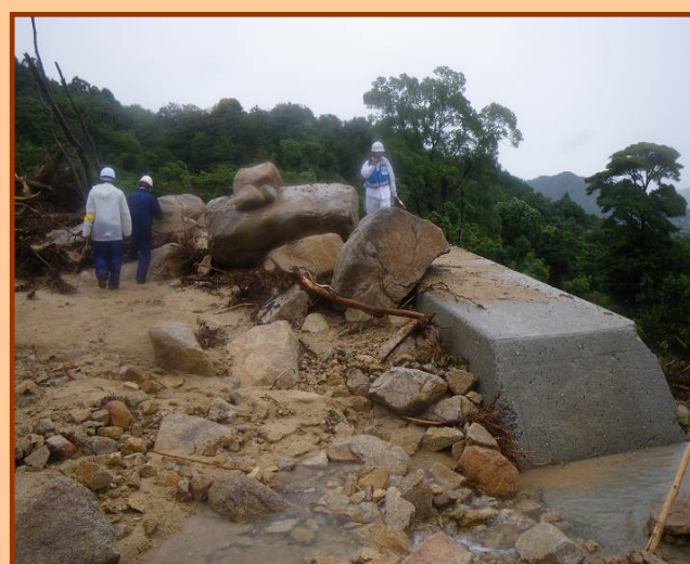
▲ 下右田地区調査状況
