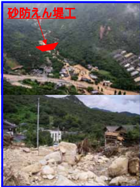
剣川(つるぎがわ) 砂防えん堤工 1基(高さ9m)
