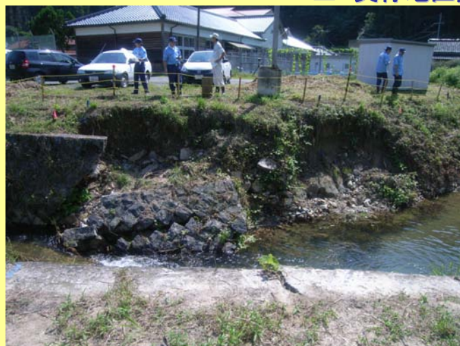
▲ 美祢地区調査状況(河川)
