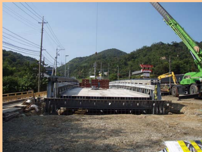
▲ 応急組立橋梁 架設完了 (一般国道262号)
