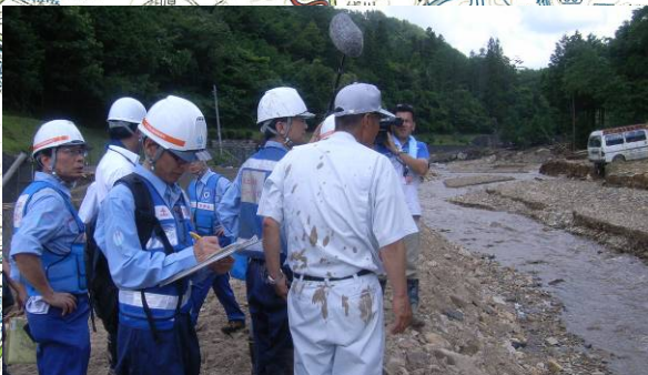
高度技術指導班(災害緊急調査) 災害復旧等指導(7月18日) 県道中迫川北線
