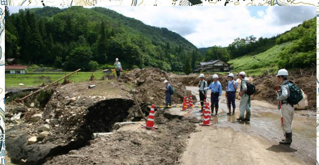
高度技術指導班(砂防関係) 土砂流出の危険性調査(7月19日) 大戸川・大津恵川
