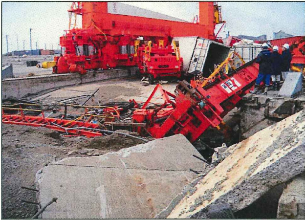
仙台塩釜港 被害状況調査(港湾班)
