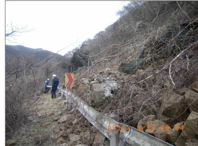
3/15 国道被災状況調査・迂回路調査
