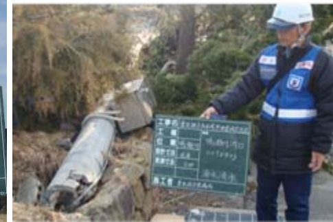
CCTVカメラの被災状況を調査
