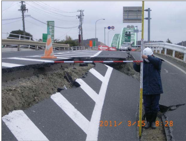
3/15 国道45号被災状況調査
