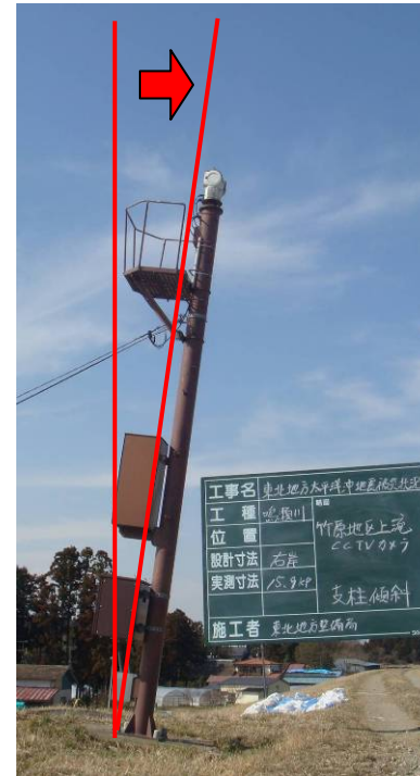
CCTVカメラの被災状況を調査
