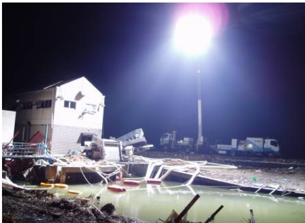
行方不明者の捜索活動を支援するための排水作業及び夜間照明を実施(宮城県東松島市)
