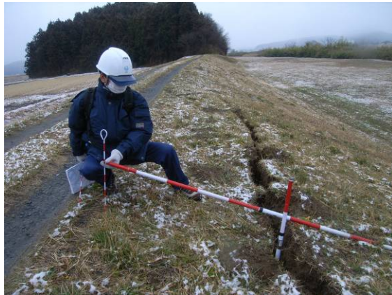
3/16 旧北上川支川(江合川) 被災状況調査
