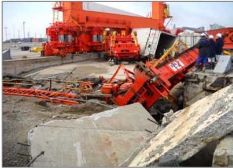
仙台塩釜港 被災状況調査
