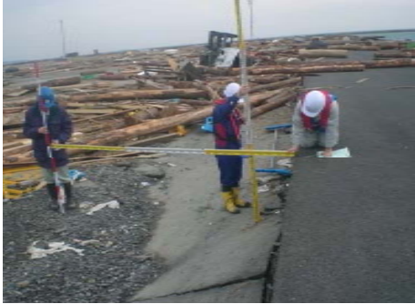
石巻港 被災状況調査
