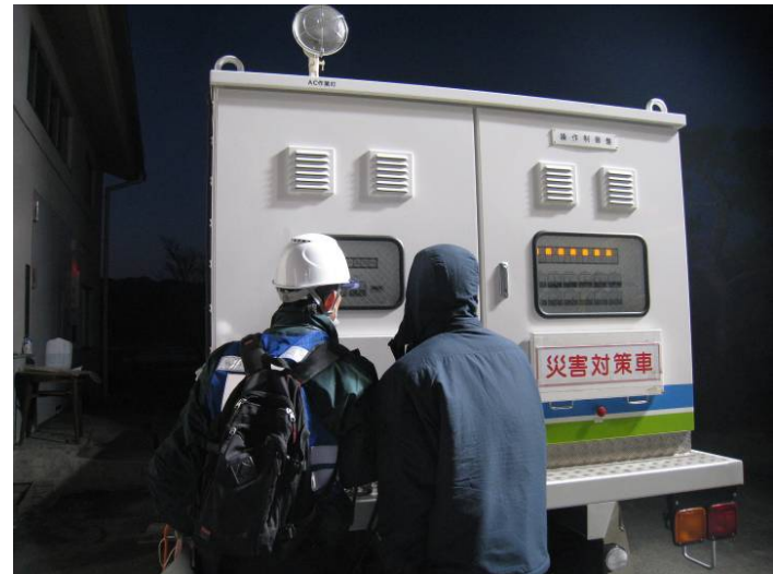
排水ポンプ車運転の注意事項を現場スタッフに指導
