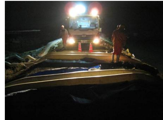
名取川(宮城県名取市)における排水状況
