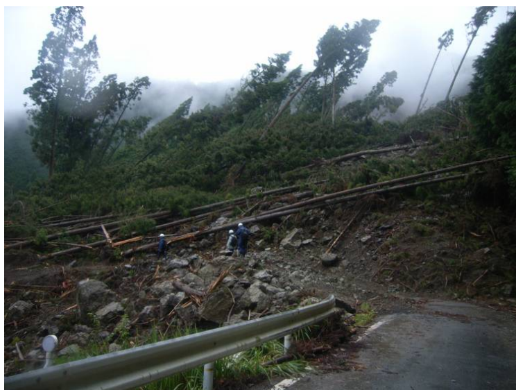
奈良県天川村坪内地区 土砂崩壊箇所の現地調査
