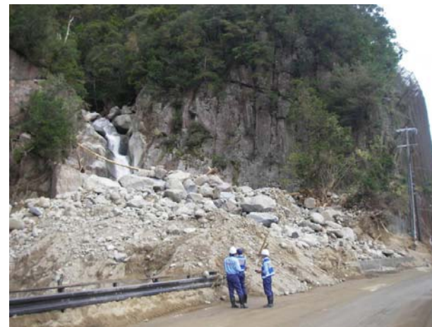
和歌山県新宮市 溪流土砂堆積 土石流発生箇所の被災状況調査
