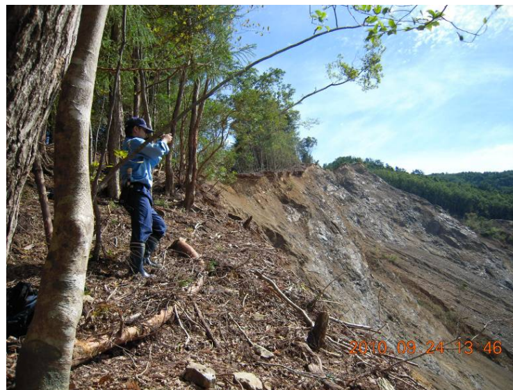
奈良県十津川村長殿地区 河道閉塞箇所の現地調査
