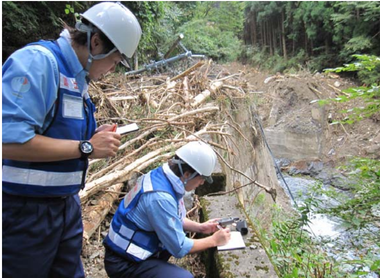
奈良県東吉野村麦谷地区 土砂災害現場での調査(座標データ取得)
