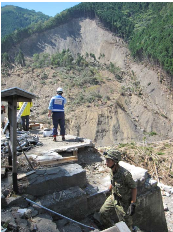
奈良県十津川村 宇井地区の被災状況調査
