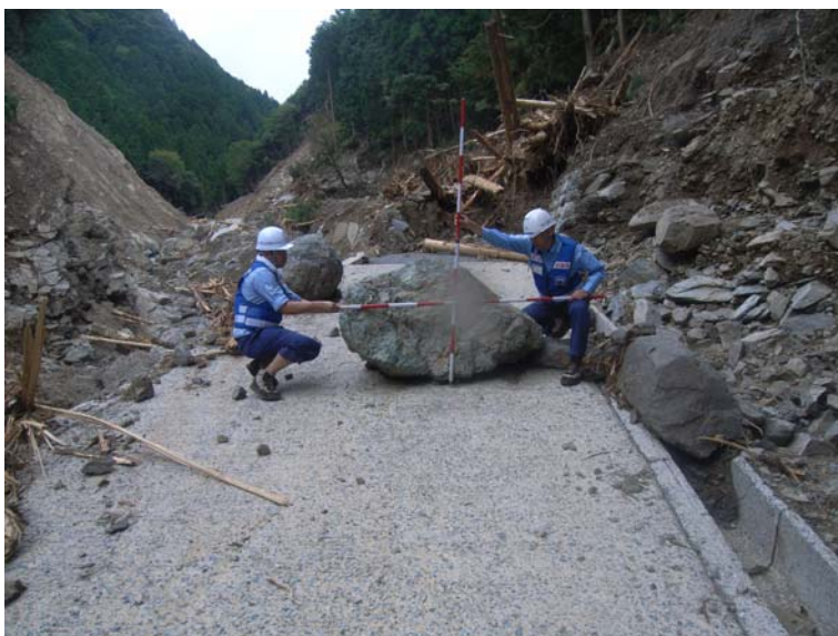
奈良県東吉野村麦谷地区 土砂災害現場での調査(礫の寸法を調査)
