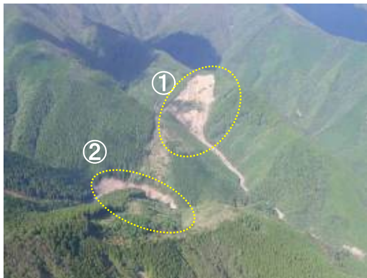
奈良県十津川村小井谷地区 (①地すべり状況・②斜面崩落状況)
