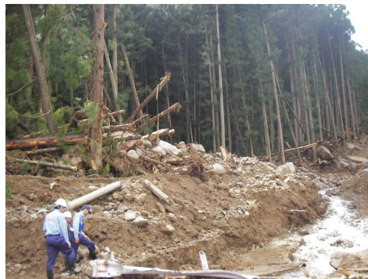
和歌山県新宮市 土石流発生箇所の被災状況調査
