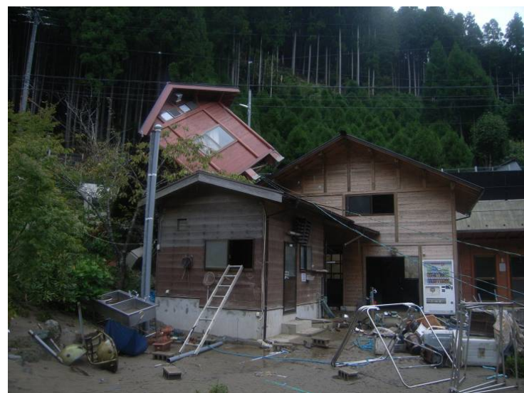
奈良県天川村坪内地区の被災状況
