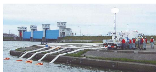
排水ポンプ車の稼働光景(イメージ)
