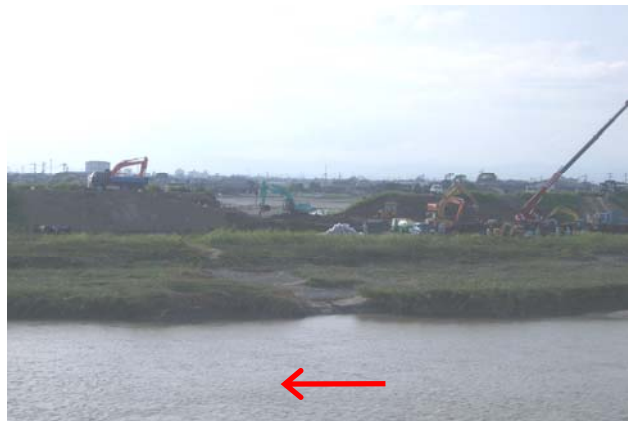
矢部川右岸7k300の破堤状況
