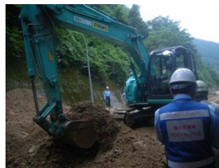
国道315号金山谷トンネル坑口付近で土砂撤去作業の指示を行う道路班
