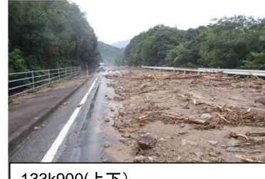
133k900(上下) 下り線法面崩落 50m×20~30m(H) 上下線に崩土有り 28日11時40分 上下通行止め →29日17時 啓開 作業車通行可
