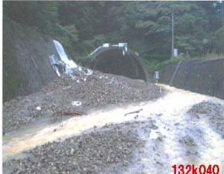
132k040(上下) 土砂流出 28日11時40分 上下通行止め →28日21時 啓開 作業車通行可
