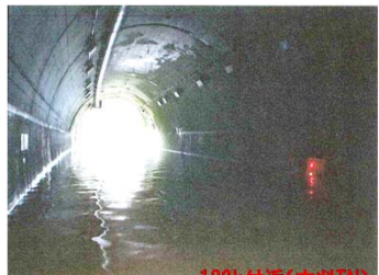
131k800~132k040 大刈トンネル内冠水 28日11時40分 上下通行止め →28日21時 啓開 作業車通行可
