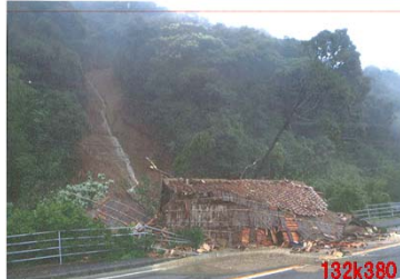
132k380(下) 民家裏山崩落 28日11時40分 下り線通行止め →28日21時 啓開 作業車通行可
