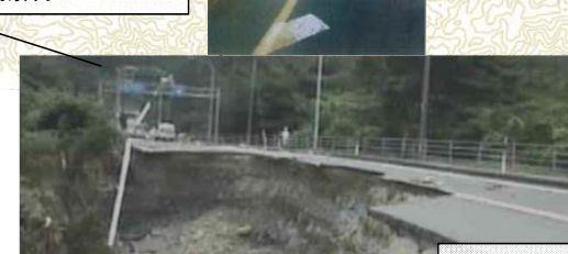
133k800(上下) 道路崩落(上り2車線)L=48m SL=20m 28日11時40分 上下通行止め →解放時期未定
