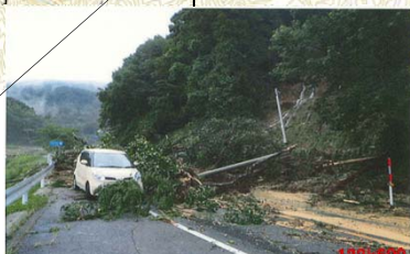
132k600(上下) 崩土・倒木L=60m 28日11時40分 上下線通行止め →28日21時 啓開 作業車通行可
