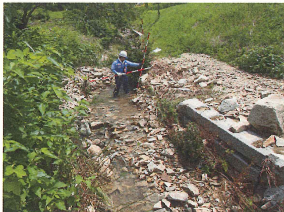
中国地整 TEC (7/31 砂防班調査)
