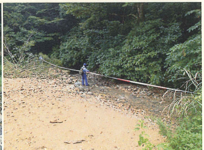
砂防班による被災状況調査
