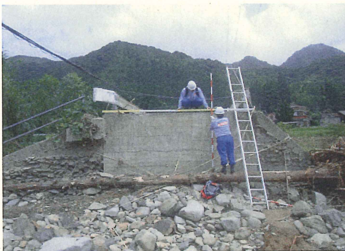
道路班②による被災状況調査
