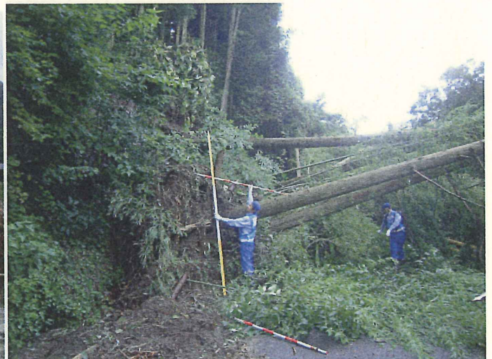
道路班③による被災状況調査
