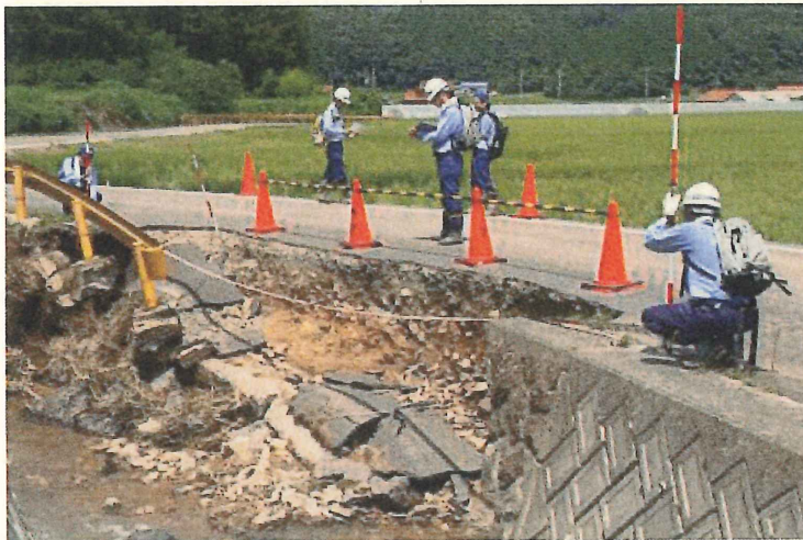
河川班による被災状況調査 阿武川支川大迫川の護岸被災箇所
