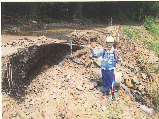
河川班②による被災状況調査状況 四国地方整備局TEC-FORCE
