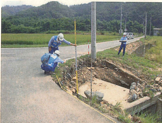
道路班③による被災状況調査状況
