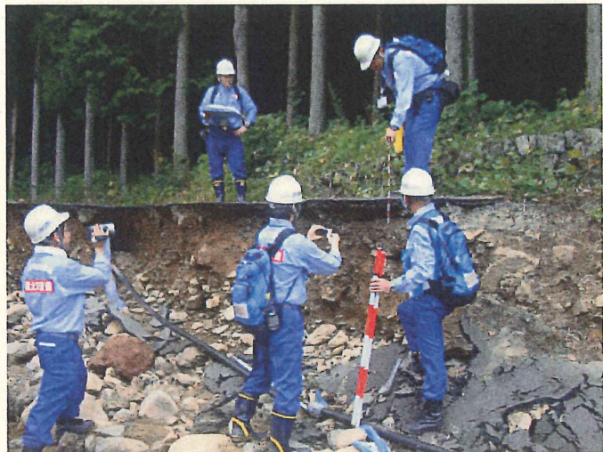
河川班②による被災状況調査状況
