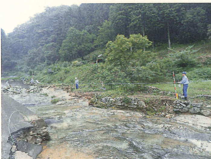
河川班①による被災状況調査
