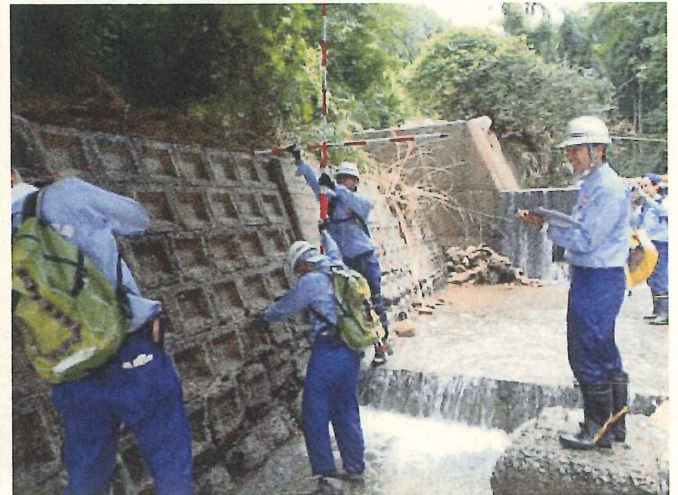
河川班による被災状況調査 奥畑堰堤
